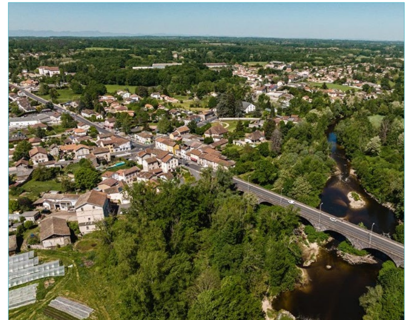
Développement de l'urbanisation au sein de la végétation à Pont de Dore (Peschadoires) - © Florian Bompan
