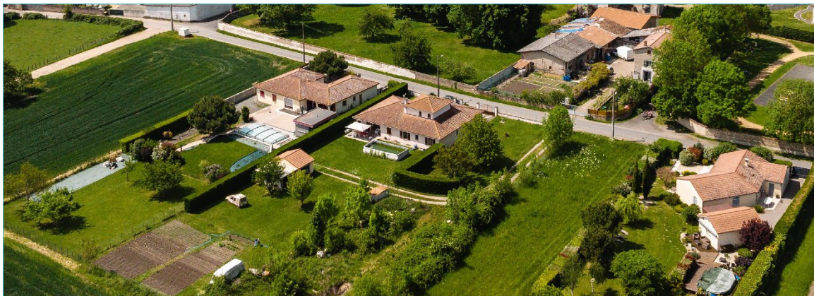
Exemple d'habitat pavillonnaire de plain-pied et de forme complexe à Culhat - © Florian Bompan
