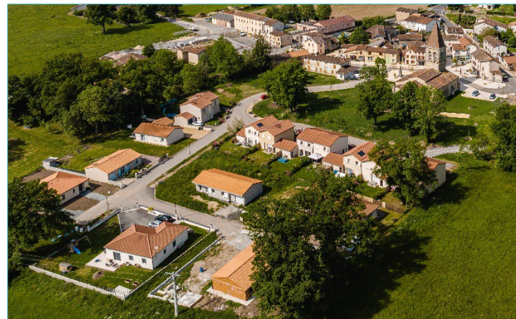
Quelques constructions récentes sous forme d'habitat intermédiaire et sur limites séparatives à Orléat - © Florian Bompan
