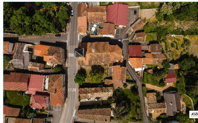
Toitures à Joze - © Florian Bompan
