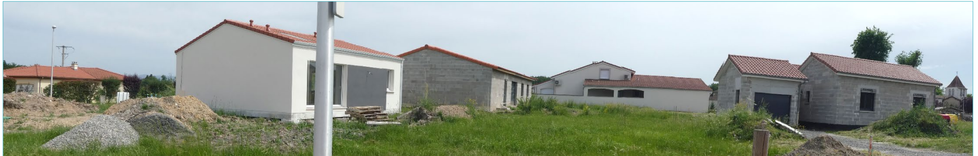
Constructions pavillonnaires en cours à Saint-Jean-d'Heurs - © Campus Développement
