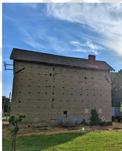
Construction traditionnelle en pisé à Vinzelles
