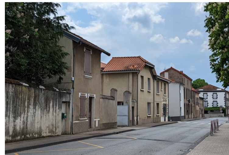
Linéaire bâti à réhabiliter à Jozé @Relief urbanisme
